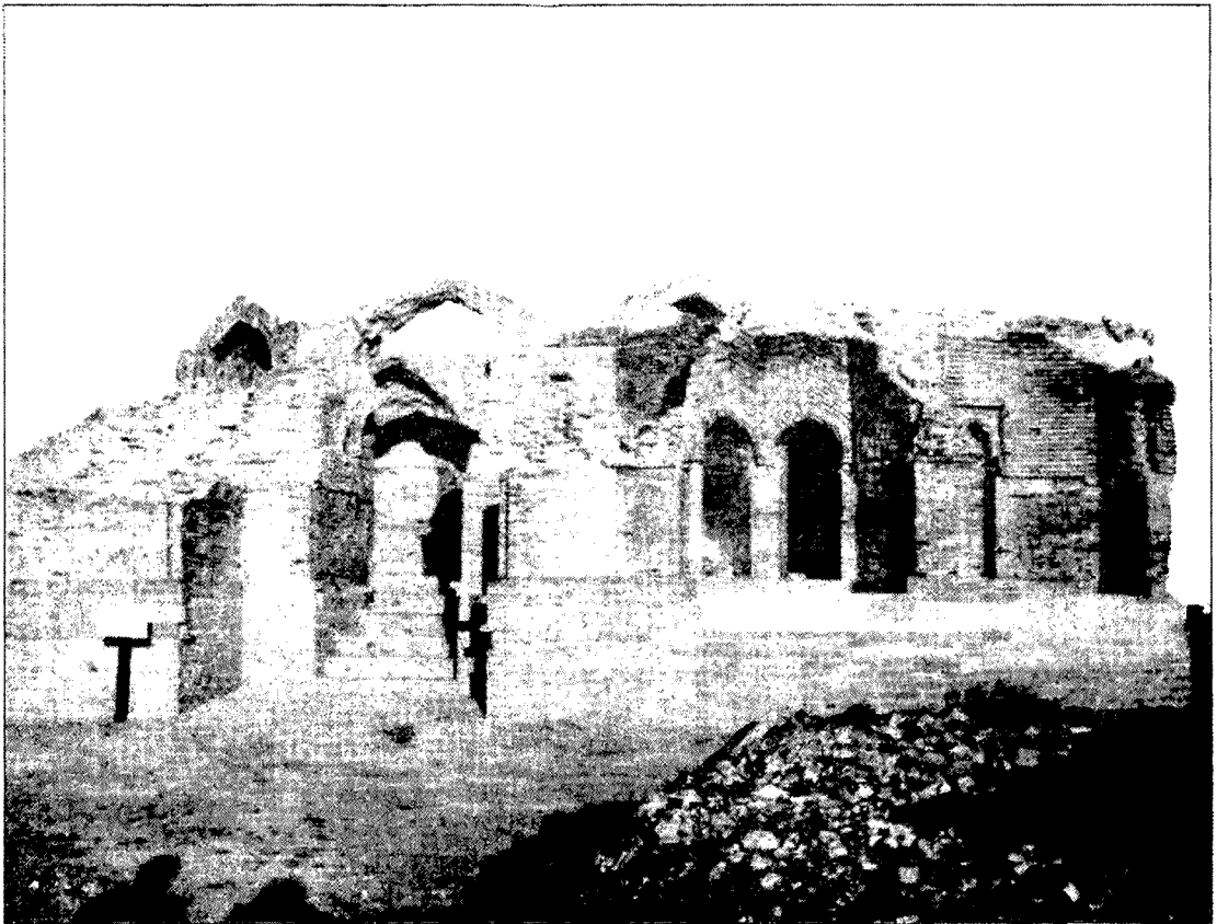
تصوير 124 - ست چوٽئي جو ڏڪڻ - اولهه پاسو. جنهن جي مکيه لنگهه واري ڏاڪڻ کي ست ڏاڪا آهن. جيڪي وچ تي نظر اچي رهيا آهن. بنيادن وٽ پٿرن جي اوساري ڏسجي ٿي. ڪنڊن وٽ ٽي محرابي لنگهه آهن. هن اڏاوت جو واسطو 16 صدي عيسويءَ جي آخري حصي سان آهي.
