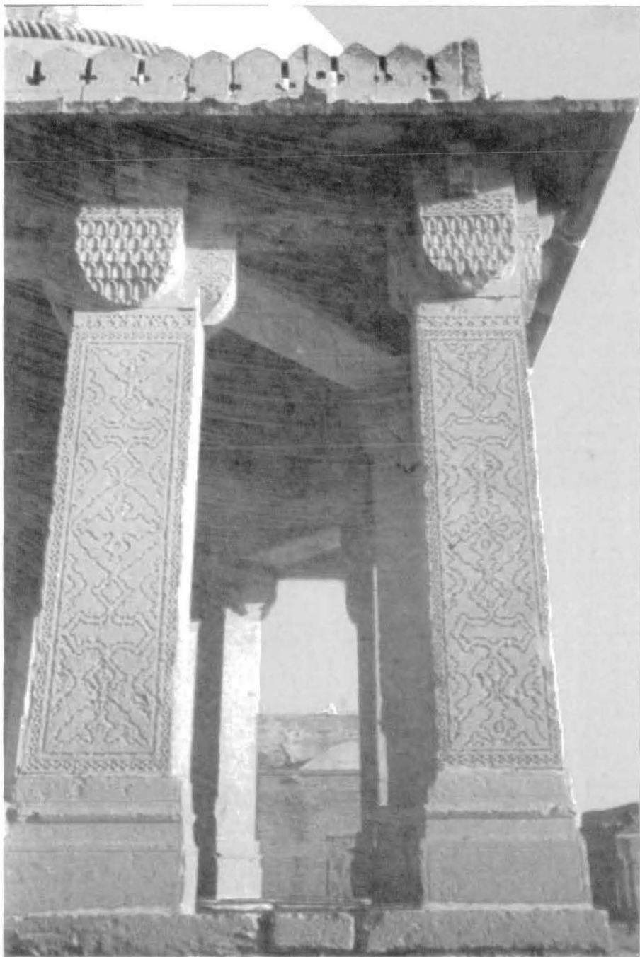
پليٽ 29 - طغرل بيگ جي مقبري جا هر چورس ماپ جا ٿنڀ، جن تي چٽساليءَ جو خوبصورت نمونو نظر اچي ٿو ۽ سردر ٿنڀن تي رکيل آهن. جڏهن ته ڪنڊن وارن ٿنڀن تي ٽي سردر رکيل ڏسجن ٿا. هن مقبري ۾ اڪير جي هڪ نئين طرز نظر اچي ٿي.
